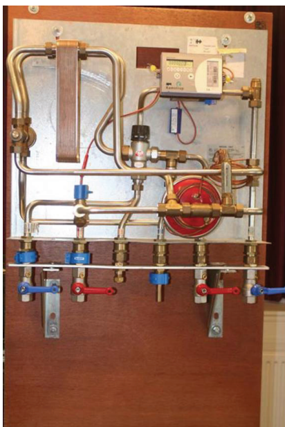
Afb. 13.6 Binnenwerk van een afleverset
