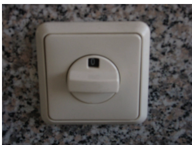
Afb. 11.9 Driestandenschakelaar voor ventilatie
