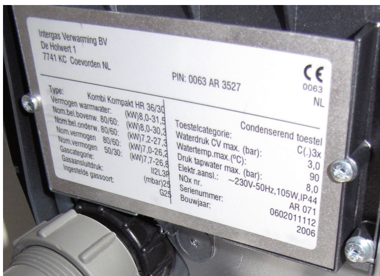
Afb. 9.4 Voorbeeld 4: Nominaal vermogen gasketels, nominaal vermogen 26,8 kW
