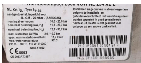
Afb. 9.3 Voorbeeld 3: Nominaal vermogen gasketels, nominaal vermogen 25 kW
