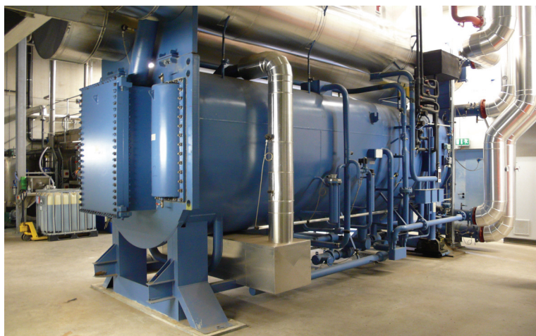
Afb. 10.8 Voorbeeld van een absorptiemachine
