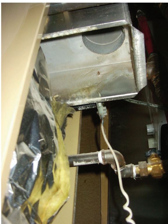
Afb. B.8 Open toestel met trekonderbreker
