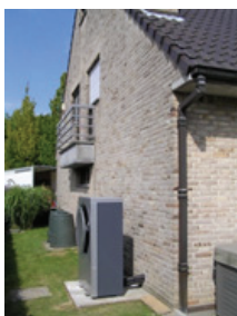
Afb. C.4 Buitenunit lucht/water-warmtepomp
