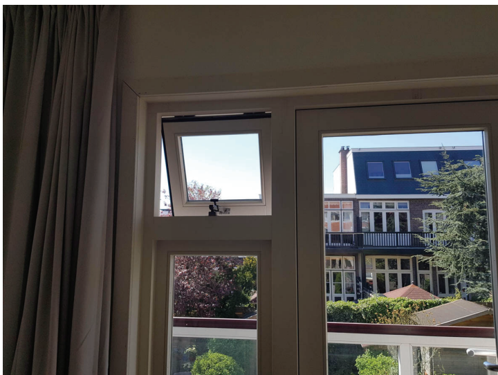
Afb. 11.2 Klepraam voor natuurlijke luchttoevoer
