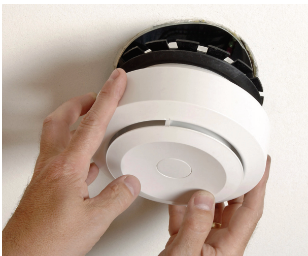
Afb. 11.6 Toevoerrooster mechanische ventilatie
