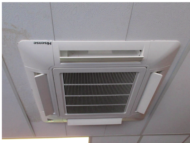
Afb. 10.4 Binnenunit van een splitsysteem (verdamper)
