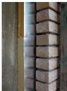
Afb. I.1 Isolatiemateriaal sluit goed aan op het binnengevelblad en het isolatiemateriaal sluit ook goed op elkaar aan. Let op: bij een reflecterende laag moet de spouw minimaal 20 mm zijn, omdat anders de stralingsfolie met de lage emissiecoëfficiënt niet bijdraagt aan de warmteweerstand (bron: Nieman)
