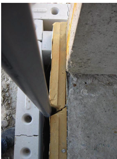
Afb. I.8 Onderbreking van het isolatiemateriaal
