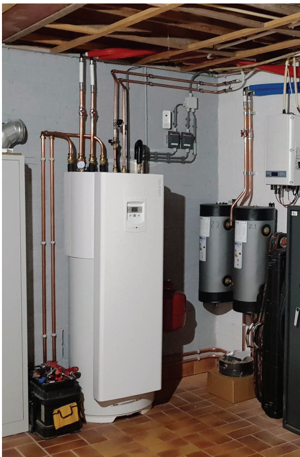
Afb. C.5 Binnenunit lucht/water-warmtepomp
