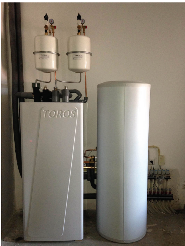
Afb. C.3 Bodemwarmtepomp met boilervat
