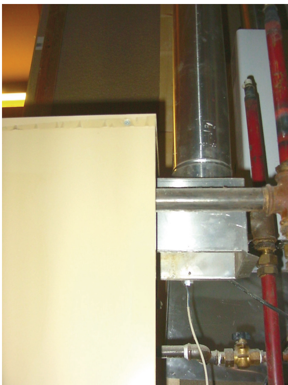
Afb. B.7 Open toestel met trekonderbreker
