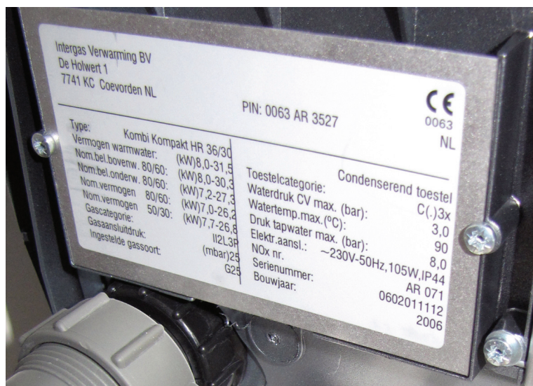
Afb. B.13 Typeplaatje van een verwarmingstoestel
