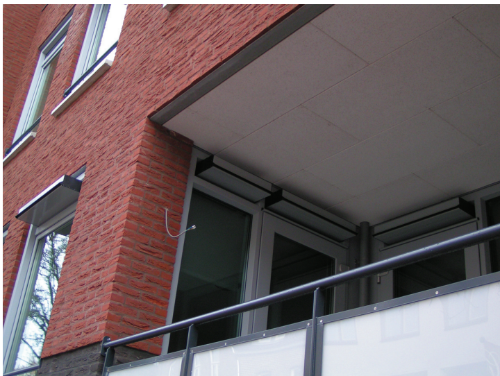
Afb. 11.3 Suskasten boven raam
