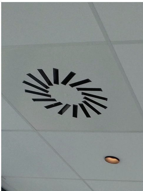
Afb. 11.5 Voorbeeld van een toevoerrooster
