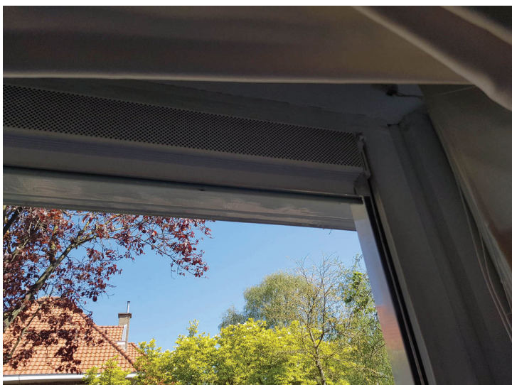
Afb. 11.1 Ventilatioerooster boven raam
