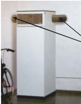
Afb. 3.38 Warmtepompboiler
