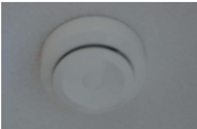
Afb. 3.51 Toevoerventiel: eenvoudig te herkennen door het uitstekende plaatje waardoor de luchtverspreiding in de ruimte wordt bevorderd
