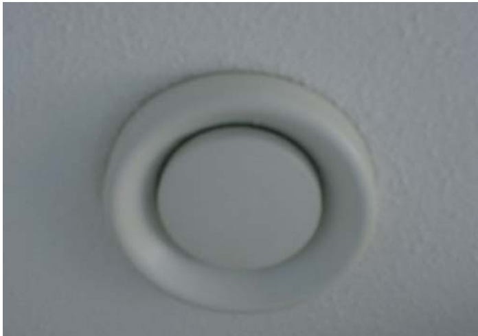
Afb. 3.47 Afvoerventiel: eenvoudig te herkennen door de vorm in vergelijking met toevoerventiel
