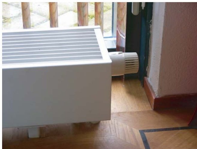
Afb. 3.22 Vrijstaande convector met omkasting
