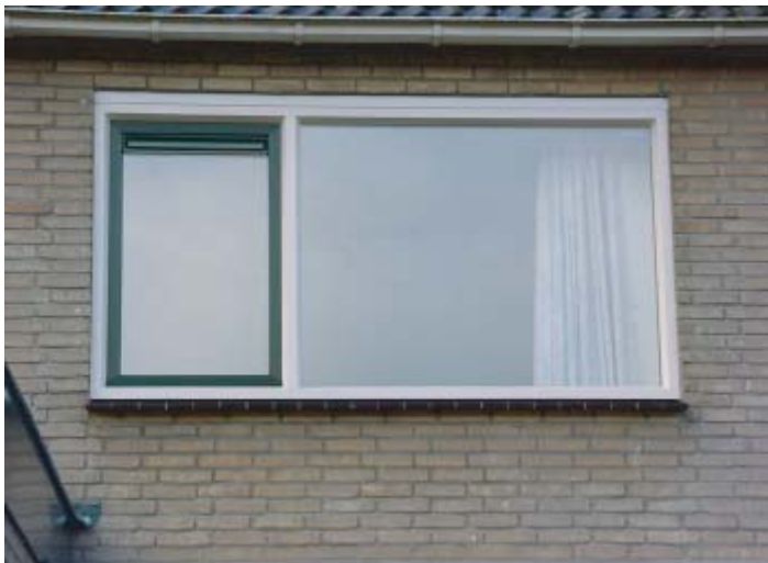
Afb. 3.44 Rooster boven draairaam
