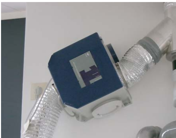
Afb. 3.46 Ventilatie-unit (ventilatiebox)
