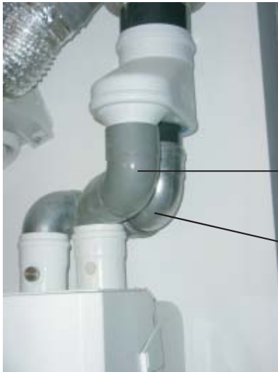
Afb. 3.14 Gesloten toestel: aansluiting van verbrandingsluchttoevoer en rookgasafvoer
